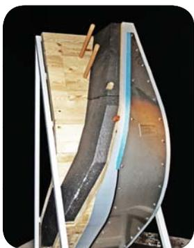
Figure 5 : Un module de mur vu en coupe.
