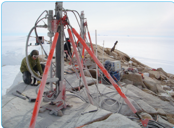
Figuur 25: Het boren van de ankerpunten
