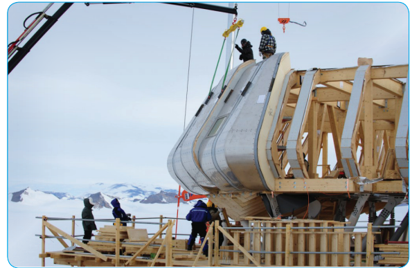
Figuur 26: De buitenmuren worden aangebracht op het houten skelet, dat op haar beurt op de peilers steunt
