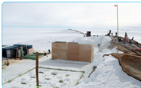
Figuur 23: Aan de voet van de richel worden de garages opgetrokken uit hout. Op de top worden de ankerpunten bepaald en geboord
