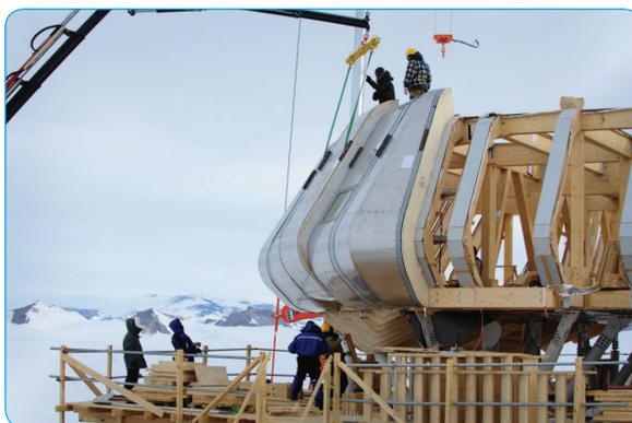
Figure 26 : Les murs extérieurs sont fixés sur le squelette en bois, qui repose à son tour sur les pilotis
