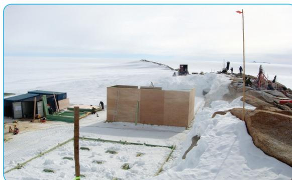
Figure 23 : Au pied de la crête, les garages sont construits en bois. Au sommet, on localise et on creuse les points d'ancrage.
