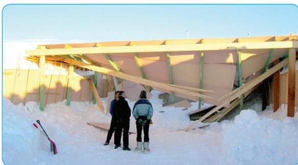
Figure 19 : Le toit du garage écroulé
